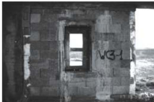
nonostante l'esplosione le pareti fatte con blocchi legno cemento sono rimaste intiere
