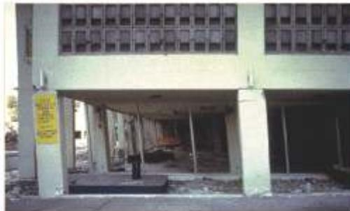
Cedimento dei pilastri è sufficiente il cedimento di un pilastro per rendere instabile l'edificio
