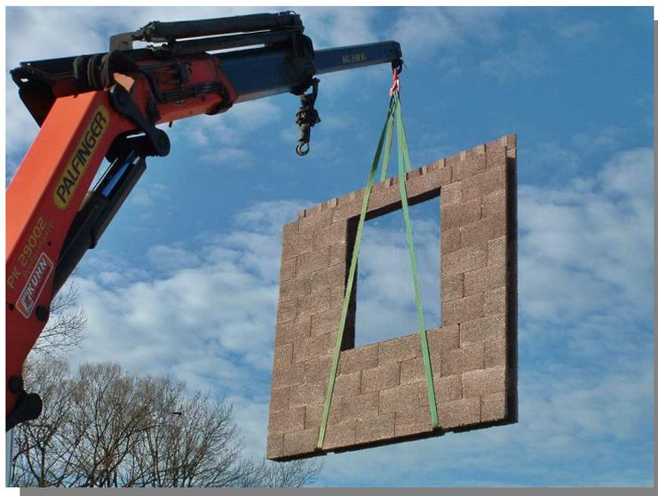
DURISOL- Hohlwände maximale Größe 5,00 m x 3,00 m
